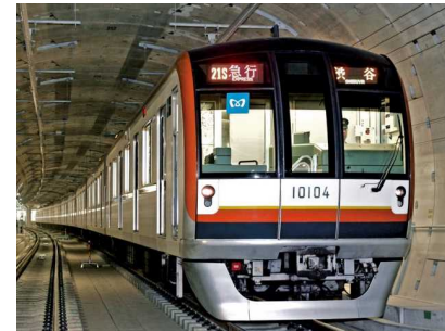
地下トンネルによる専用軌道
