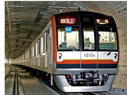
地下トンネルによる専用軌道
